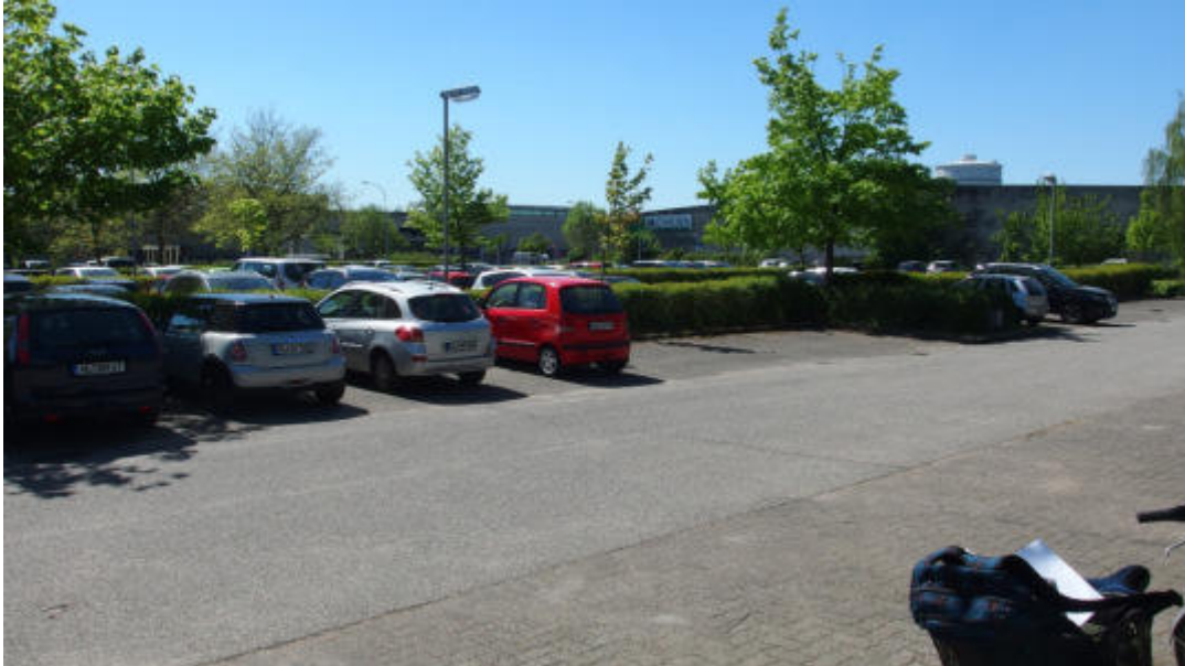
Abb. 4: Blick nach Südosten über die Parkplatzfläche, die Verkehrswege sind mit Asphalt versiegelt, die Parkbuchten mit Verbundsteinpflaster.
